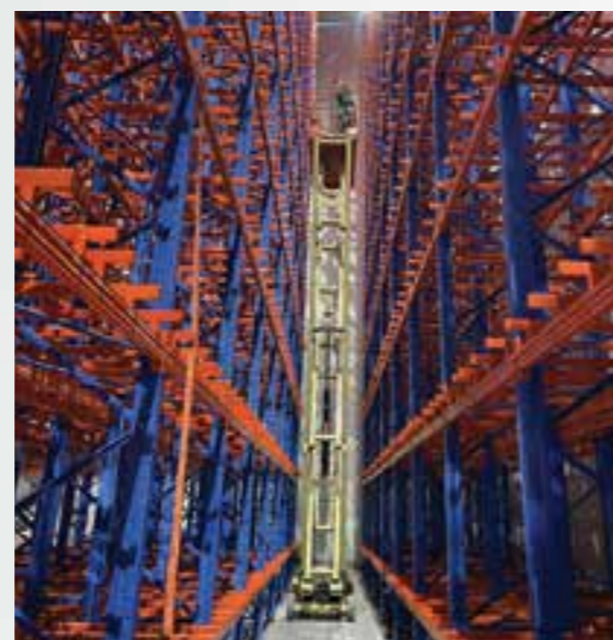
Hình ảnh nhân viên Searefico E&C đang thực hiện thao tác, lắp đặt thiết bị tại dự án Kho lạnh thông minh do Công ty thực hiện.
